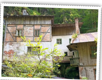
Eine ehemalige, verfallene Mühle steht am Beginn der Wanderung durch die Seisenbergklamm
